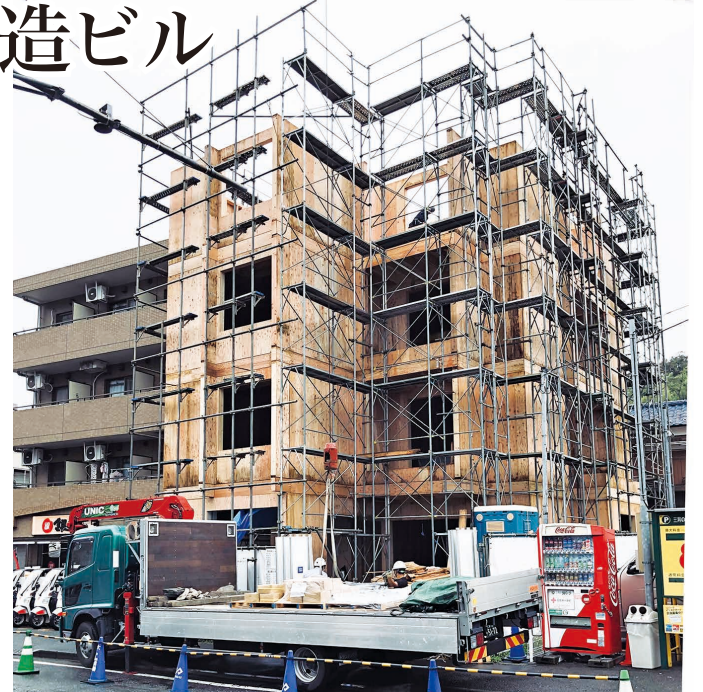
構造見学会を行った建築中の木造ビル
