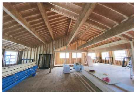
施工中の様子
